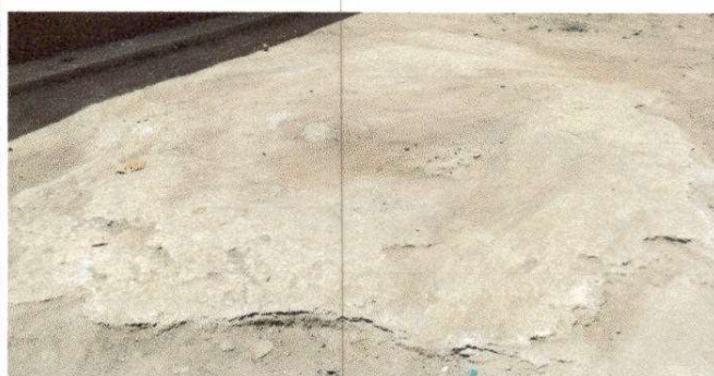
Foto 4: Sustitución de piso de torta de concreto
